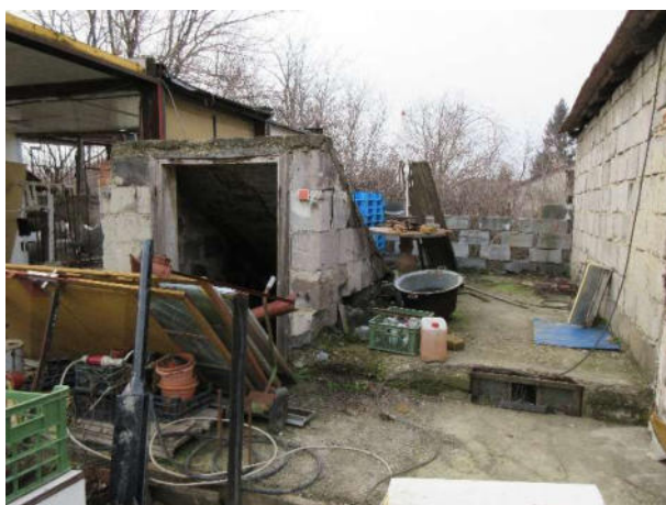
Vchod do pivnice
