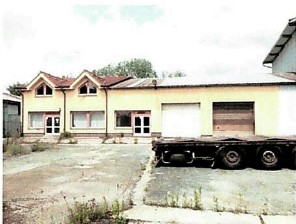
Administratívna budova a hala na p.č. 9470/8
