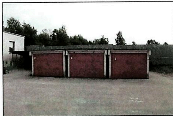
Garáže na východnej hranici parc. č. 1943/40 – bez súp. č.
