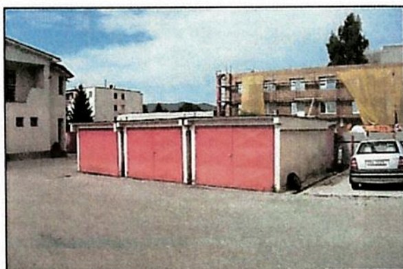
Garáže na západnej hranici parc. č. 1943/40 – bez súp. č.
