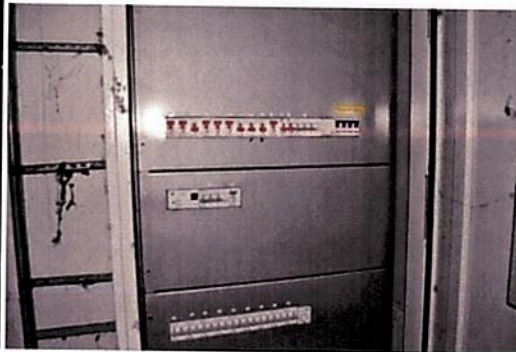
Rozvádzače elektriny pre kompresorové jednotky
