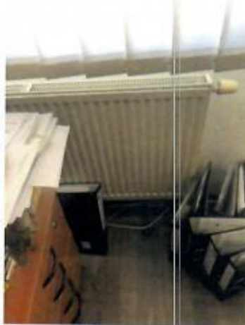
ocelové panelové radiátory
