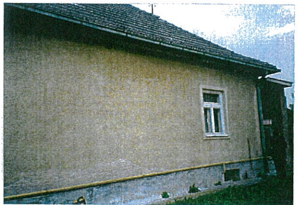
POHLED Z VÝCHODU
